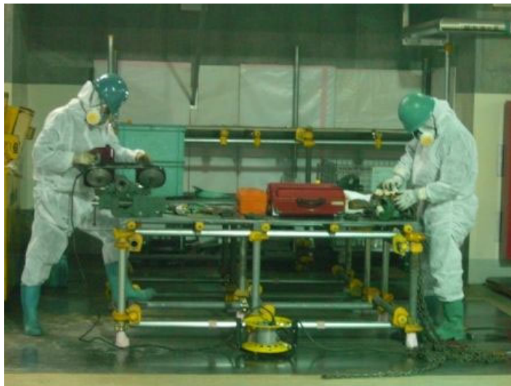
第 27－9 図 切断作業の状況
