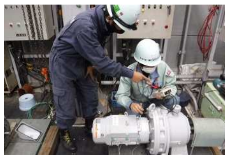
電動機点検作業
