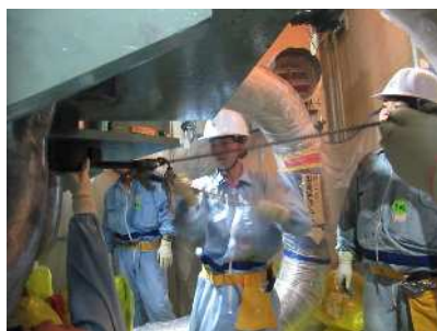
弁取外し作業
