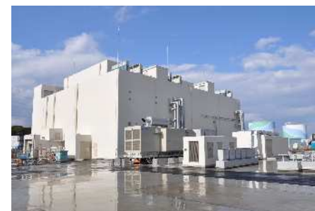
川内 緊急時対策棟 外観
