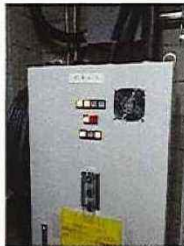
電源切替盤(局舎内)
