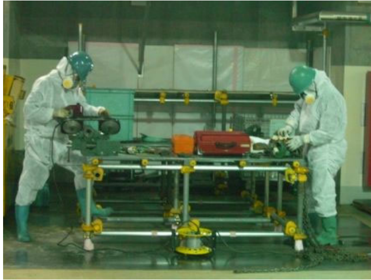
第 27－9 図 切断作業の状況
