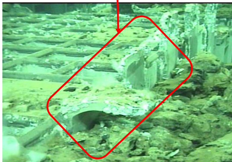
吊りピース変形
