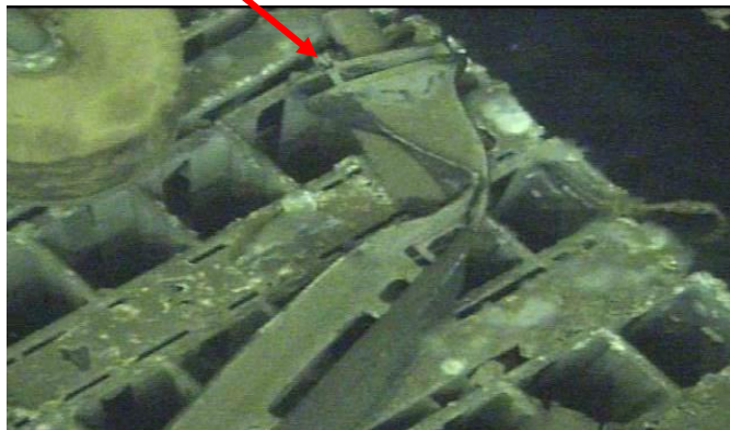
制御棒下部に変形
