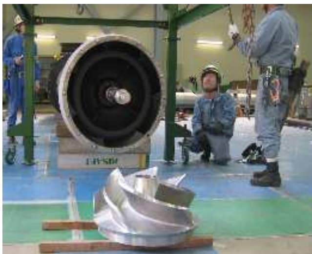
【海水ポンプ分解点検状況】
