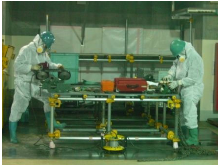
第 27－9 図 切断作業の状況
