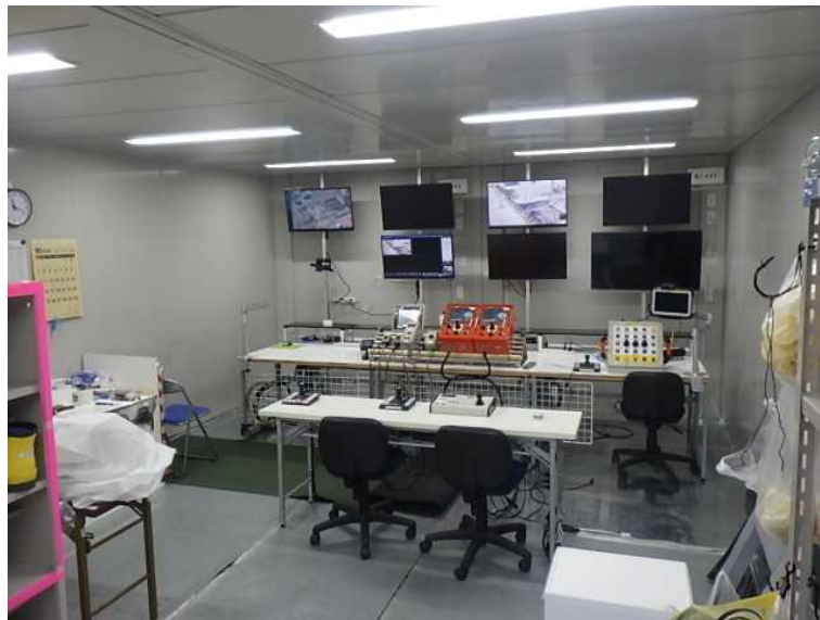
遠隔操作室イメージ (例：2号機地盤改良工事)
