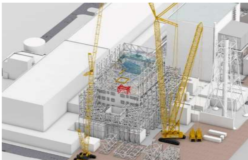
下部架構設置中
