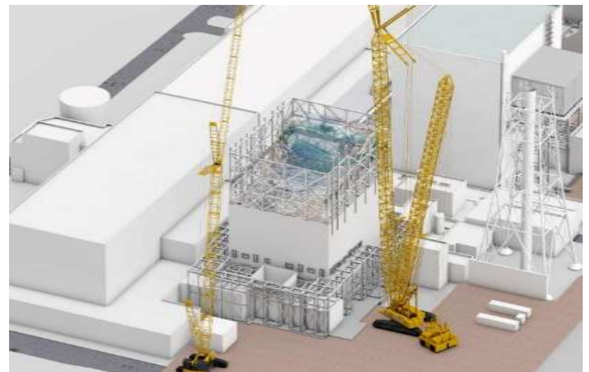
仮設構台設置完了
