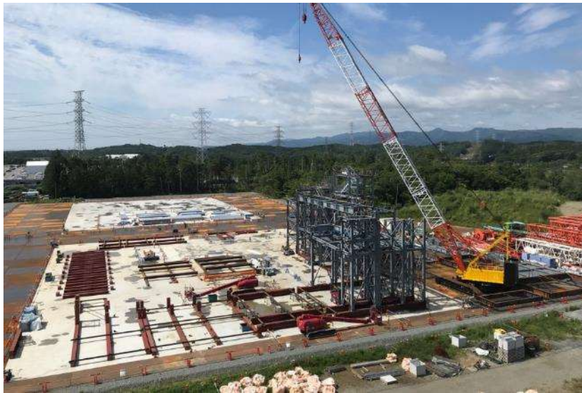
構外ヤード（低線量エリア）での鉄骨のブロック化
