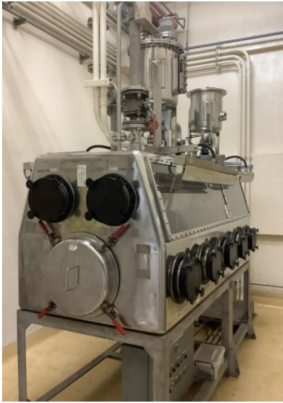
No.11グローブボックス（廃液処理装置）
