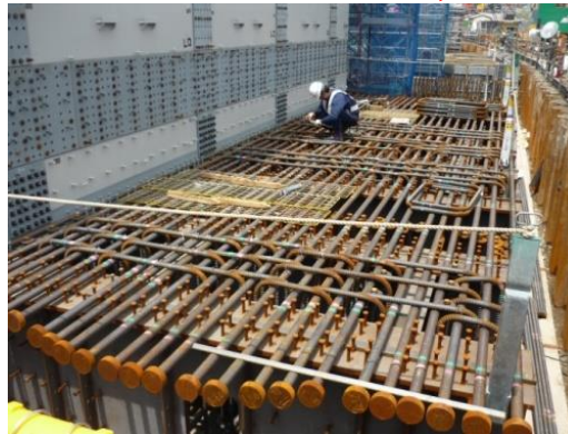
フーチング組立状況
