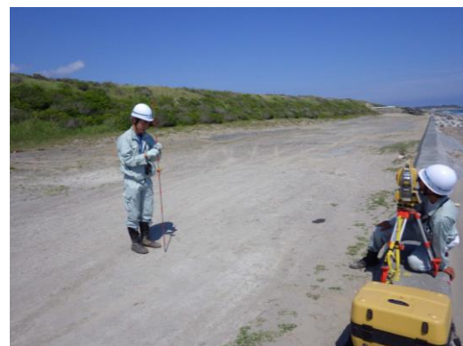
海岸線地形測量実施状況 (陸上部)
