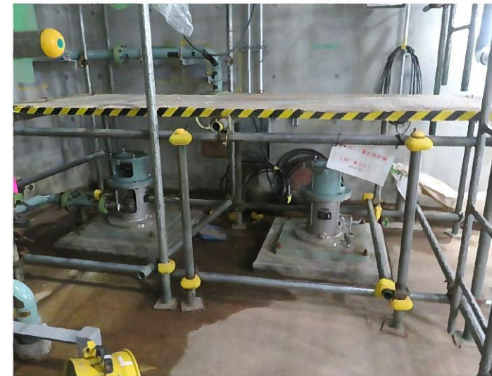
【緊急時対策棟用湧水サンプルポンプの据付状況】
