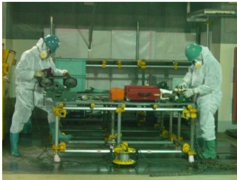
第 27-5 図 切断作業の状況
