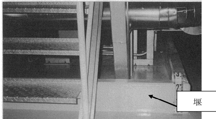
第 1-2 図 堰による拡大防止対策の例
