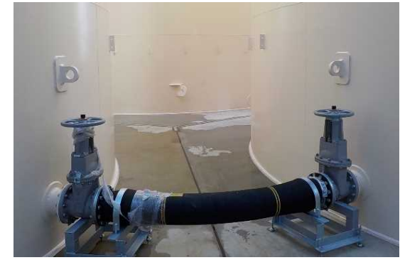
タンク連結部の写真例 (G1 南エリアの場合)
