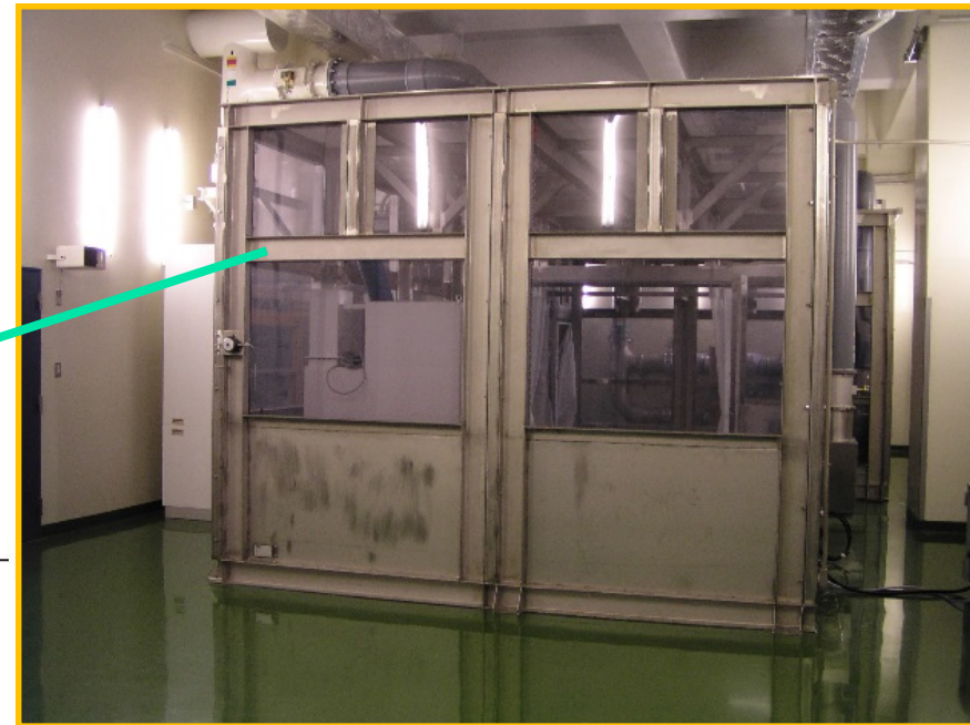
第2UWSF 詰替室 パネルハウス
