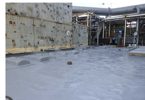
2号機Rw/B（ガレキ撤去・防水後）
