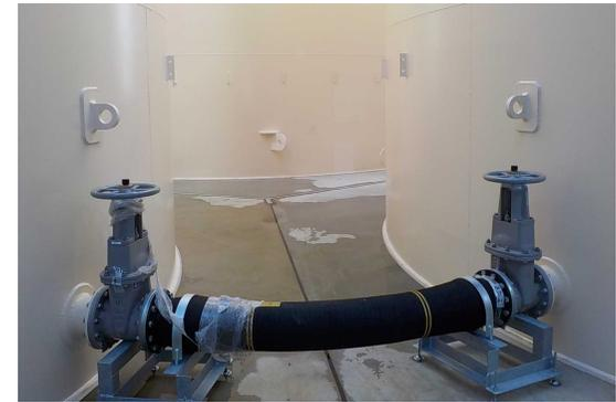
G4北・G5の連結配管(耐圧ゴムホース)は、G1・G4南エリアで使用しているものと同等品である。(製造者仕様の範囲内で運用する)
