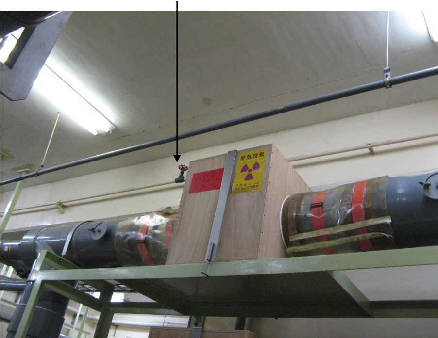
NF配管系統の取外し箇所
