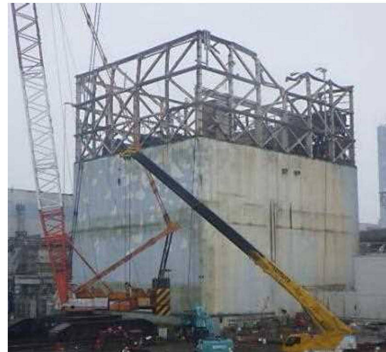
1号機原子炉建屋全景（2021年6月19日時点）
