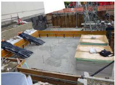
[建家間のハンドホール及び埋設管路の敷設]
