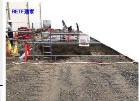
[南面工区 舗装撤去・試掘調査中]
