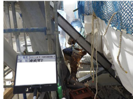
【補強部材の溶接による取付】
