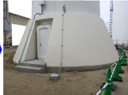
【排気筒下部補強工事完了】
