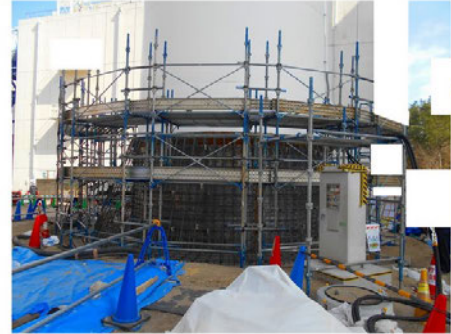
【排気筒下部への配筋施工】
