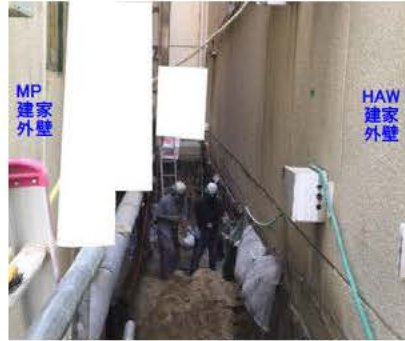
[北面工区 手作業による掘削]
