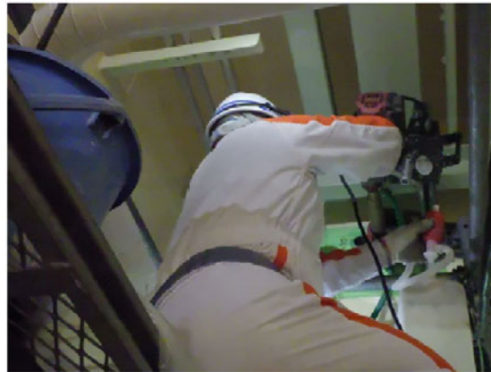
【壁のコア抜き調査】
