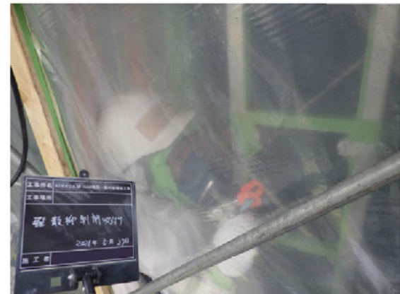
【アスベスト除去作業】
