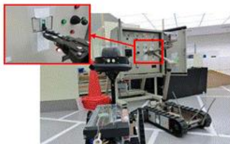
訓練施設におけるロボット操作訓練 (制御盤を開放しスイッチ操作)
