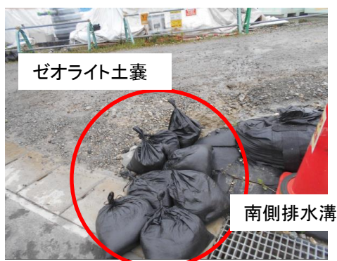
【ゼオライト土嚢設置後の南側排水溝（7/7撮影）】
