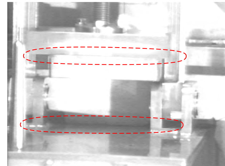
給電フィーダ側サポート受け台と給電フィーダの観察結果 (給電フィーダ側遠隔サポート緩め前)
