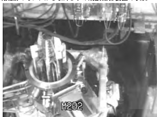
溶融炉下部より台車にて引出し中の既設結合装置の状況
