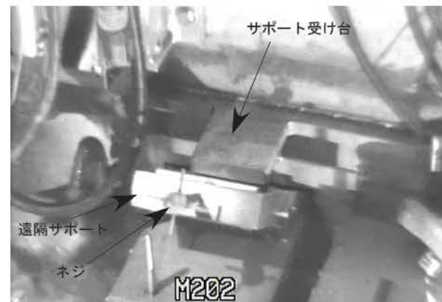
遠隔サポート及びサポート受け台の外観（固定前）
