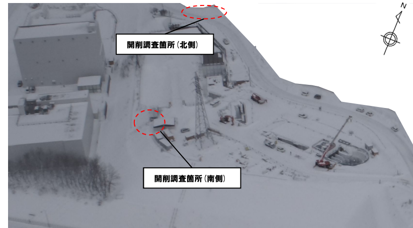
写真① 開削調査箇所(南側)付近空撮写真(平成27年1月撮影)
