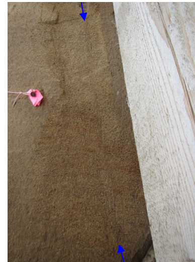
東落ち正断層(2) 拡大写真
