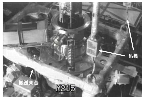
取外した既設結合装置の固化セル内移動の状況
