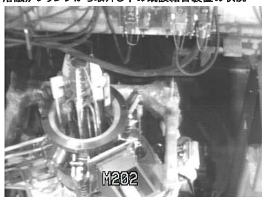
溶融炉下部より台車にて引出し中の既設結合装置の状況
