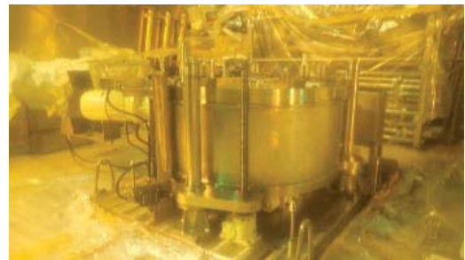
遠隔交換装置全景
