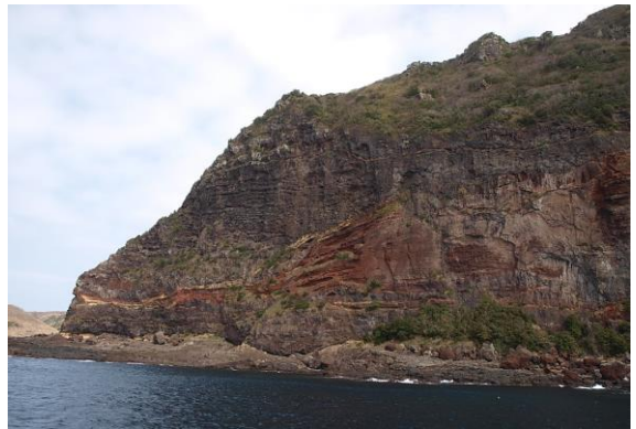
b. 岩盤崩壊箇所中央部の海食崖
