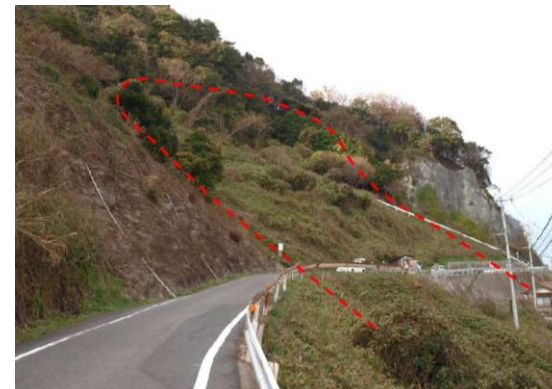
ブロック上部～中央部の斜面状況
