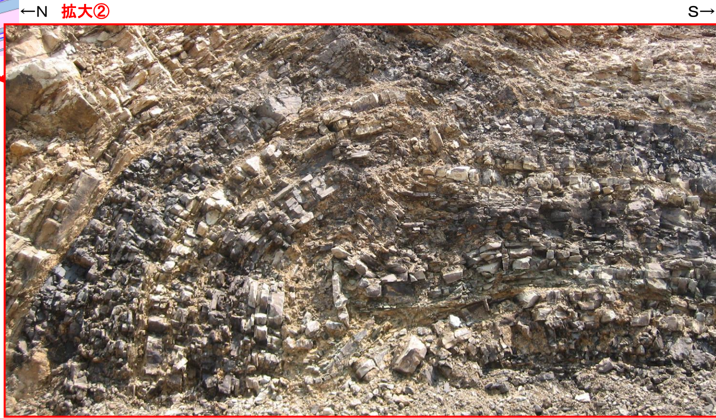
【拡大写真】 過褶曲部 近接写真
