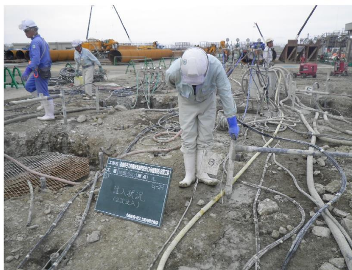
薬液注入工 状況写真(2011年撮影)
