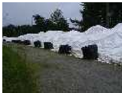
屋外シート養生
