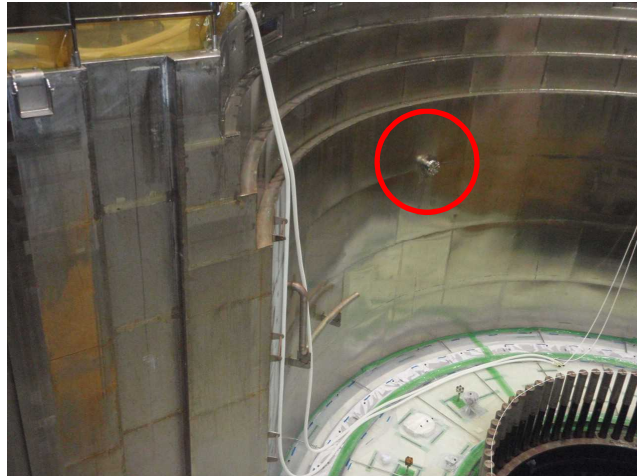
1号機 ウェル除染風景 (事故前の定検中)
