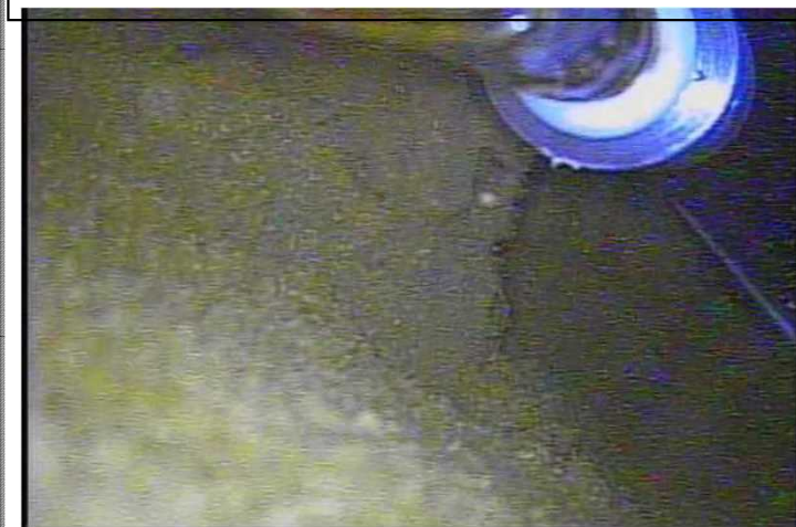
過去にPCV新設温度計・水位計設置時の画像
