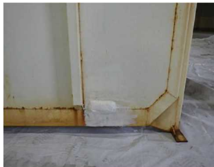
図1. 腐食箇所の補修箇所
