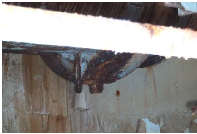
主蒸気配管 C
