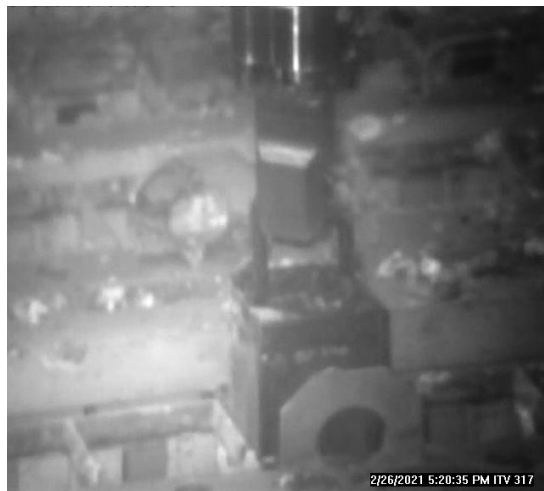
3号機での燃料の吊り上げ（566体目）
