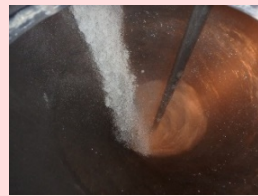
セメントの投入と混練
