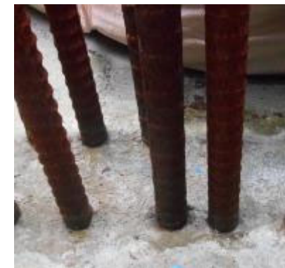
試験体根元部の状況写真
