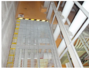
配管分岐室横のグレーチング通路
