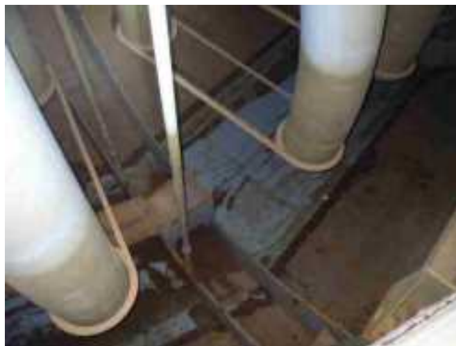
②マンホールから撮影
