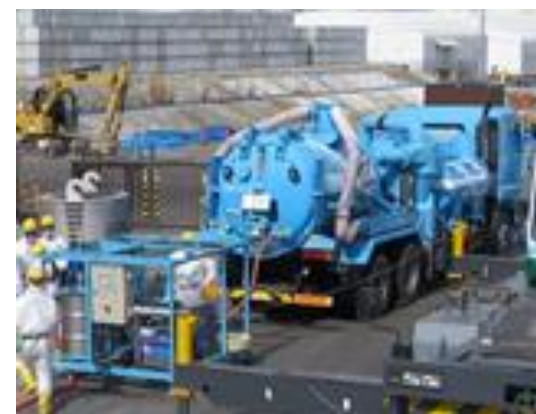
回収装置の設置
