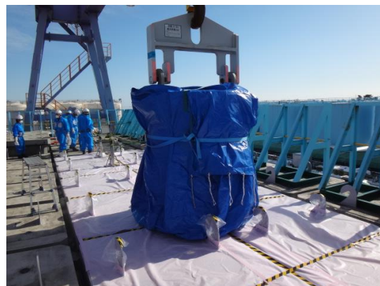
漏えい発生HICの養生
