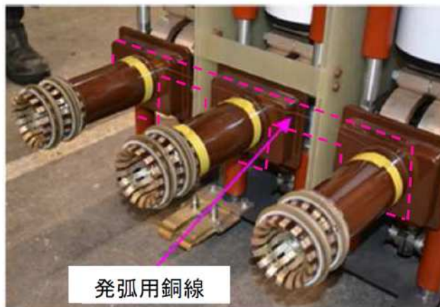
発弧線の設置状況 (遮断器 2 次側端子)
