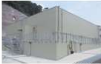
緊急時対策所
