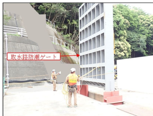
② 所定位置から地切り後、取水路角落し開口部に挿入
