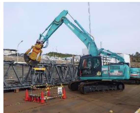
上部解体時の小割解体状況 撮影：2017.4
