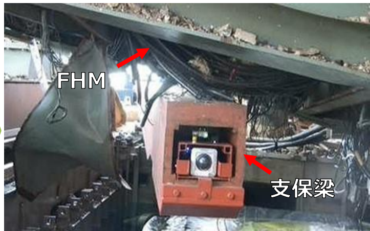
II-a. 支保梁挿入中 (撮影日: 2020.10.20)
