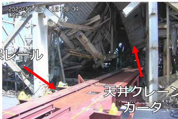
I. 支保レール設置完了 (撮影日: 2020.11.11)
