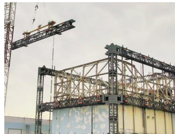
上部解体時の梁取り外し状況 撮影：2017.7
