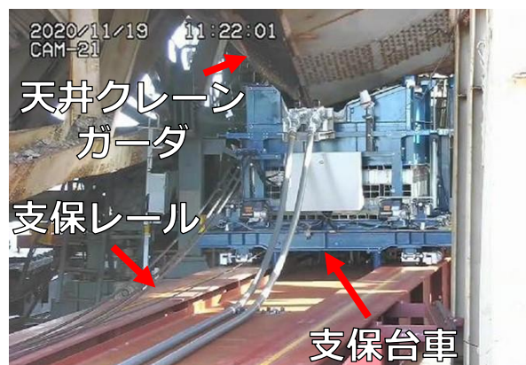
III. 支保台車設定完了 (撮影日: 2020.11.19)
