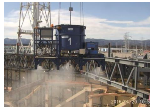
飛散防止剤散布状況
