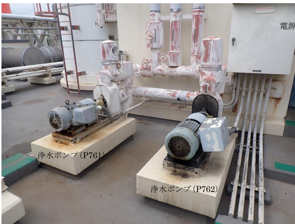
電源切替盤 (H5)、浄水ポンプ (P761、P762)
