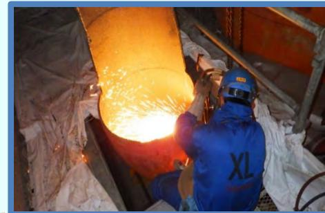
高圧タービン排気配管の切断
