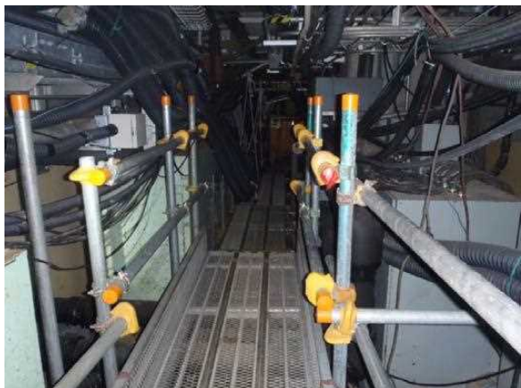
写真1：堰設置予定箇所
