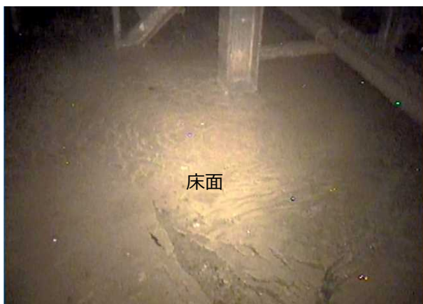
2号機タービン建屋 最下階床面
