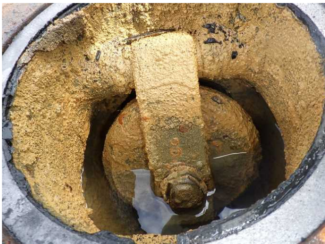
①逆止弁内部状況（一時貯留タンク側）
