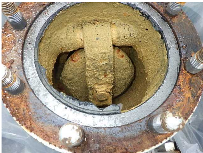
②逆止弁内部状況（ポンプ出口側）
