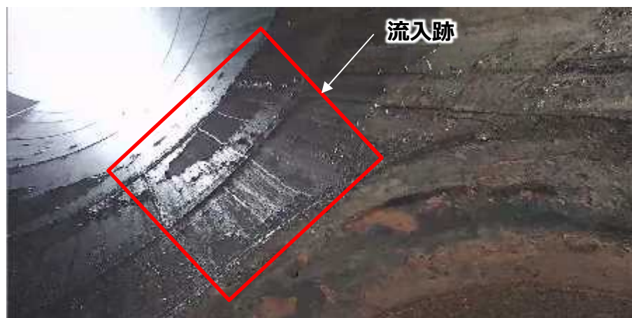
写真：排気筒内面状況（5/20雨天時）
