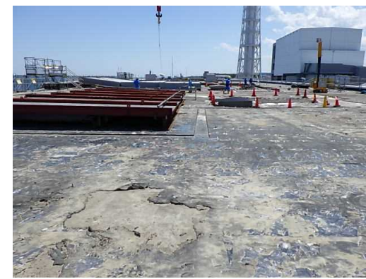
屋根ガレキ撤去の状況 〔北側から撮影〕
