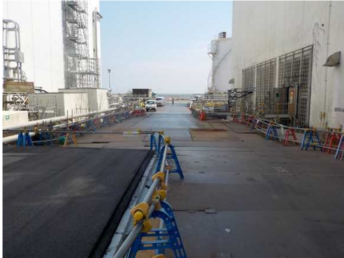
■ 2-3号間道路（海側） 状況写真 （施工前）
