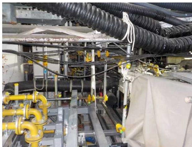
廃棄物処理建屋内の写真①
