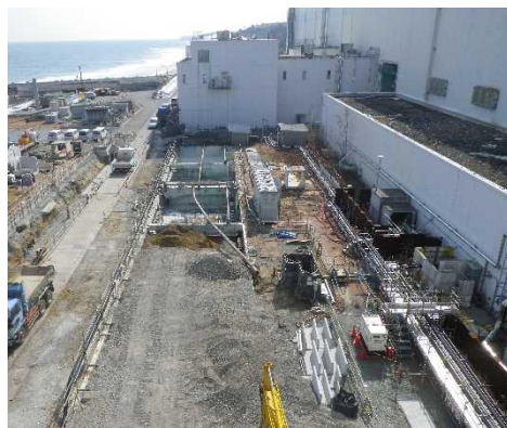
クレーンヤード整備状況【実施中】 〔北側から撮影〕
