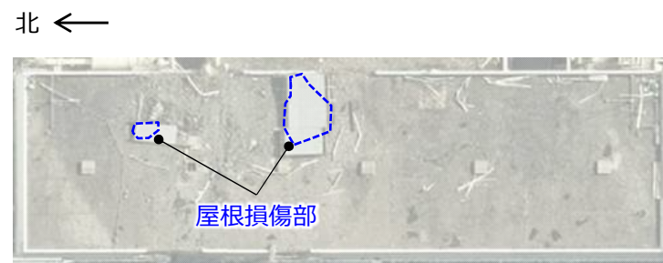
3号機タービン建屋・屋根状況【着手前】 〔上空から撮影〕
