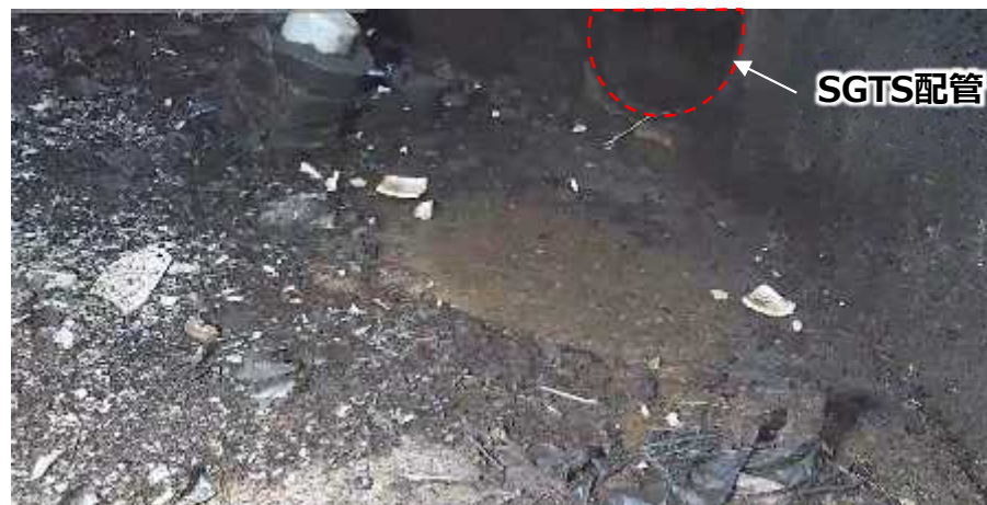
写真：SGTS配管状況（5/20雨天時）
