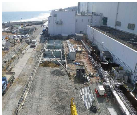
クレーンヤード整備状況【整備前】 〔北側から撮影〕
