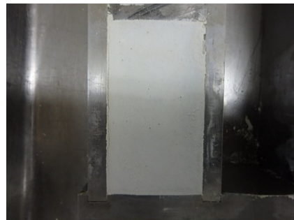
浮き水の有無の確認 (1日養生後)
