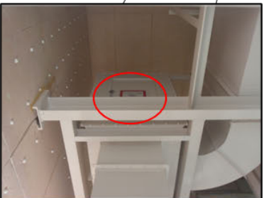
既設ダクト点検口外観
