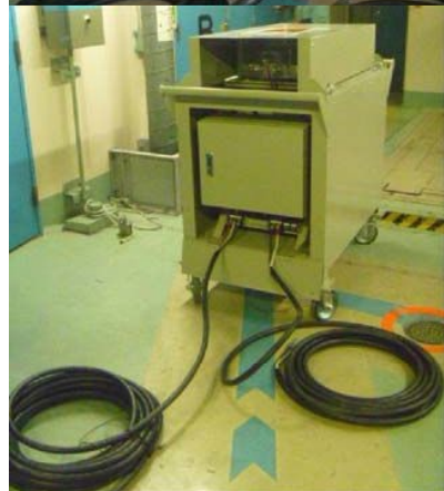
可搬式整流器への ケーブル接続
