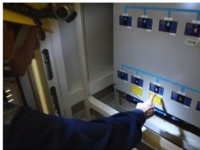
直流電源受電操作 （充電器室）
